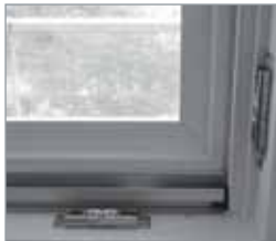
Inklemhor in houten kozijn met aluminium onderstrip
